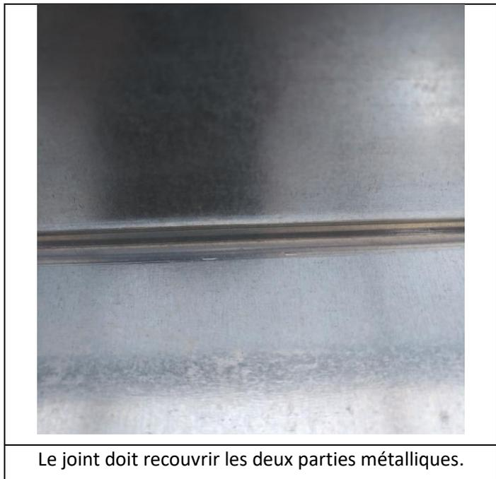
Le joint doit recouvrir les deux parties métalliques.
