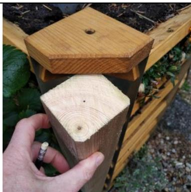
Tracer le repère de perçage et l'orientation du poteau
